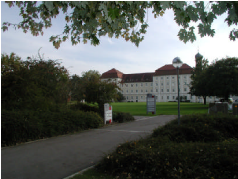
Teil des barocken Klostergebäudes Bad Schussenried, heute Psychiatrisches Zentrum
